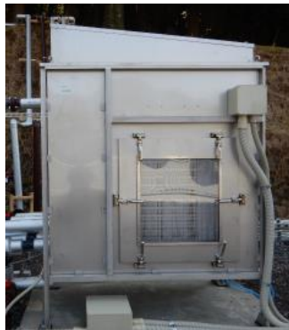
流下液膜熱交換器
