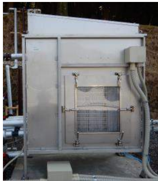
流下液膜熱交換器
