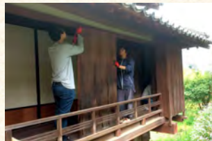
建具の修理中
